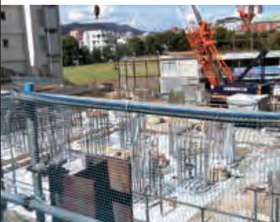
長崎大学BSL4施設建設現場
